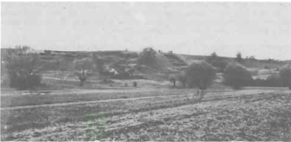
Fig. 8. Przykłady drobnych wtórnych osuwisk na zboczu doliny Wisły w Siedleszczanach Examples of small secondary slides on the slope of the Vistula Valley in Siedleszczany
